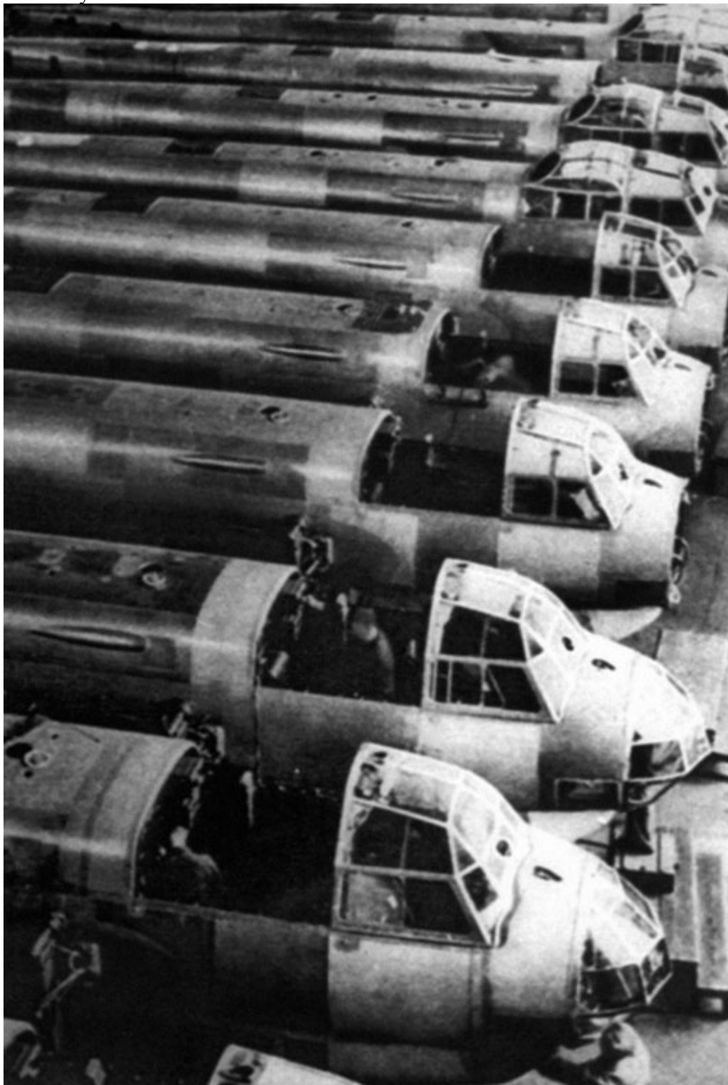
Конвейер на заводе фюзеляжей в Ашерслебене
