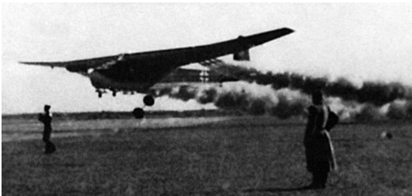
Взлет «Гиганта» с ракетными двигателями. Сброс основных колес.
