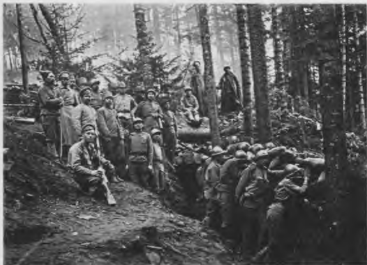
Еще окопы в лесу. Кроме глубины и начертания окопа, маскировки бруствера стоит отметить наличие убежища и касок Агриана. Любопытны также наличие шанцевого инструмента (лопаты, кирки) и «окопные вольности» в ношении снаряжения
