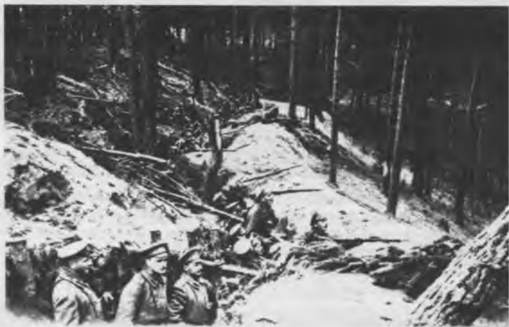
Окопы, оборудованные на склоне в лесу. 1916 г. Заметим изломы в начертании окопов
