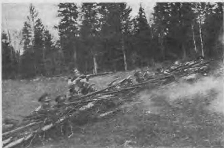
Еще один вариант быстрого устройства позиций в начале войны — просто наваленные деревья
