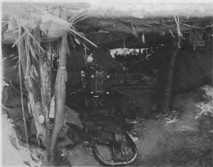
В окопах пехотного полка. Пулеметное гнездо с козырьком. На переднем плане — карабин обр. 1907 г. пулеметчика
