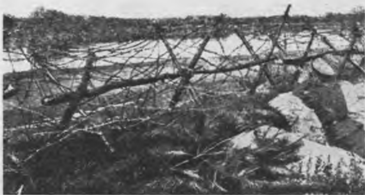
Наблюдение за противником с помощью полевого бинокля. Передовым заграждением служат простые рогатки, оплетенные проволокой
