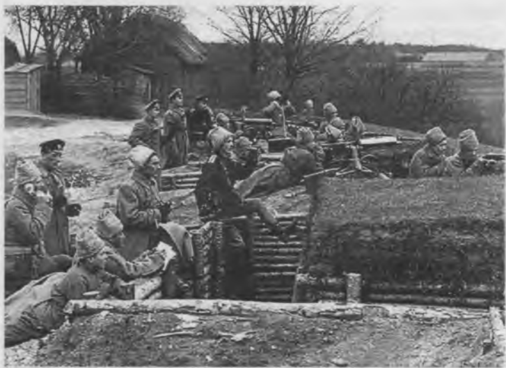
Перестрелка пулеметчиков 132-го пехотного Бендерского полка с противником на р. Двине. Октябрь 1916 г. Обратите внимание на коленчатое в плане начертание окопов, массивный бруствер, размещение пулеметов на поперечных насыпях, а также — на телефониста рядом с офицером
