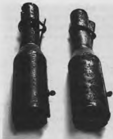
Наследники русской «бутылочки» — ручные гранаты обр. 1914/30 гг. (здесь показаны со вставленными запалами, удерживаемыми заслонкой) служили в Красной Армии еще в Великую Отечественную войну
