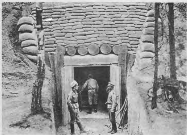
Убежище от тяжелых артиллерийских снарядов
