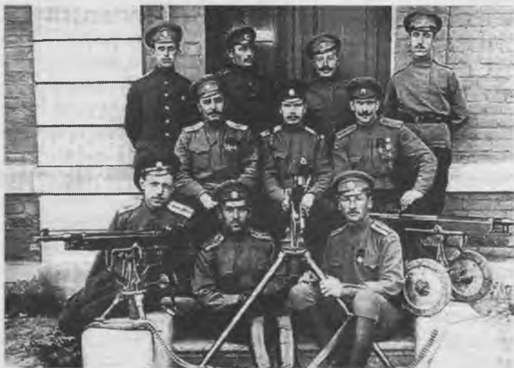
Пулеметы «Кольт» в Офицерской пулеметной школе. Обратим внимание на установки — «низкая» тренога, «высокая» тренога, опытный колесный станок
