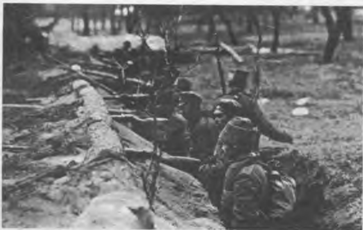
Тот же 1915 год. Для стрелков в бруствере сделаны перекрытые бойницы, бруствер пытаются маскировать. Но от артиллерийского огня такой окоп пока защищает слабо
