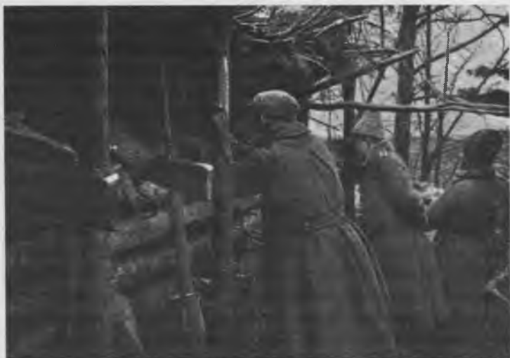
Позиции в лесу с бревенчатым бруствером с бойницами, перекрытыми прочными козырьками
