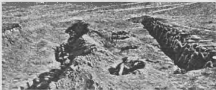
Линии окопов. 1915 г. В первом окопе плотно расположились стрелки, за ними — ячейка для командира, вторая линия — окоп для частного резерва (поддержка). Здесь не видно ни загибов окопа на флангах, ни ходов сообщения
