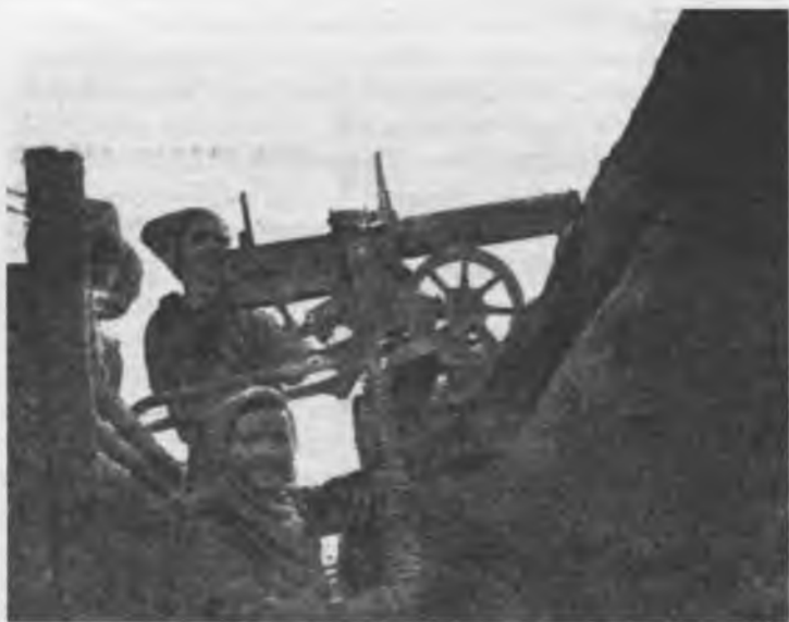
Узкий окоп позволял ставить пулемет на станке Соколова с опорой на тыльный траверс. Фотография 1916 г.
