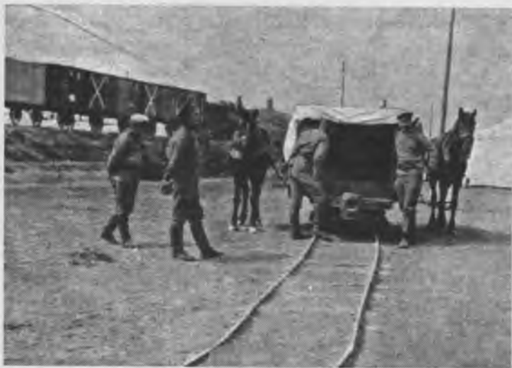
Подвоз боеприпасов войскам с помощью полевой узкоколейной железной дороги. 1916 г.
