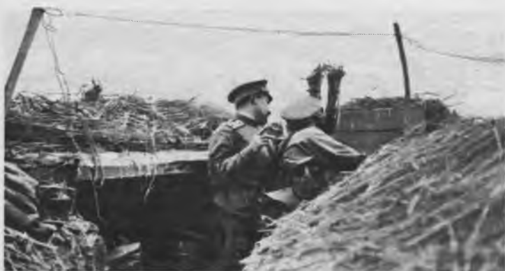
Наблюдательный пункт со стереодальномером. На кольях, вероятно, протянут телефонный провод
