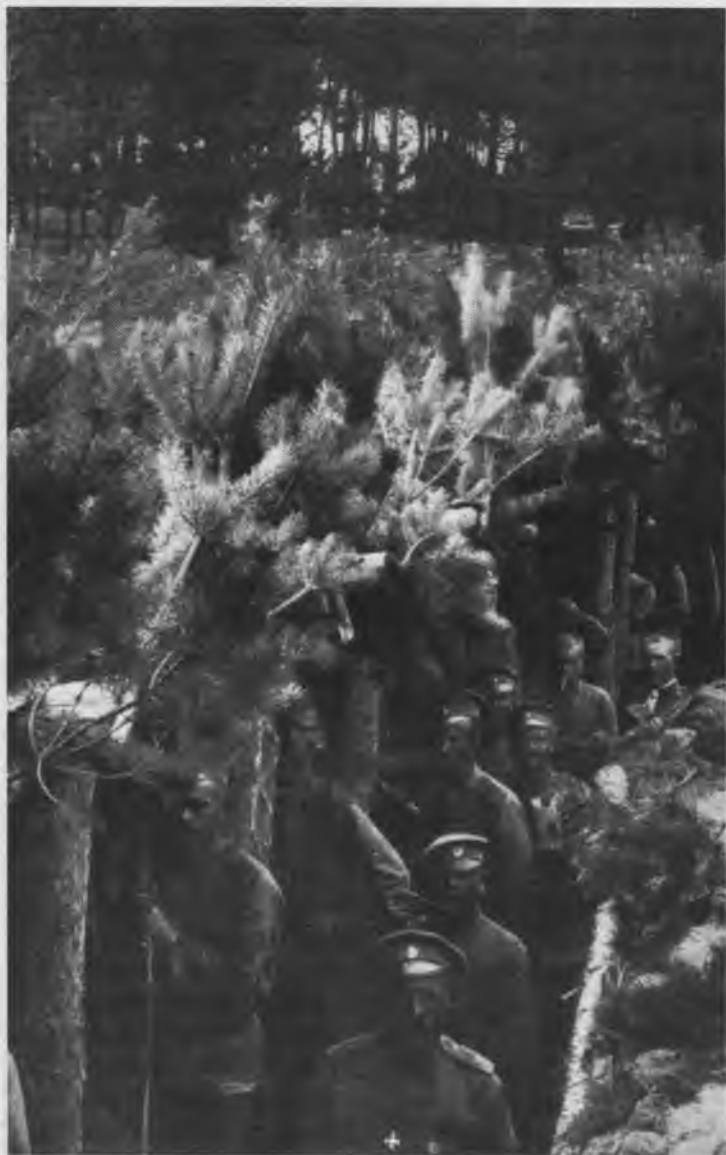
Окопы в Галиции — с обшитыми деревом стенками, противошрапнельными козырьками, маскировкой бруствера и тыльного траверса окопа
