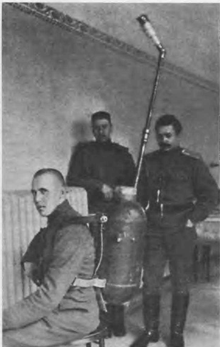
Изучение захваченного у германцев ранцевого огнемета типа «Кляйф». Этот аппарат германцы переделывали также для распыления газов и кислоты
