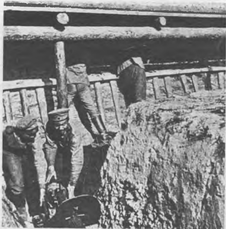
Окопы стали глубже, появляются ходы сообщения (по которым можно подтянуть стрелков и пулеметы), стрелковая ступень и т.д.
