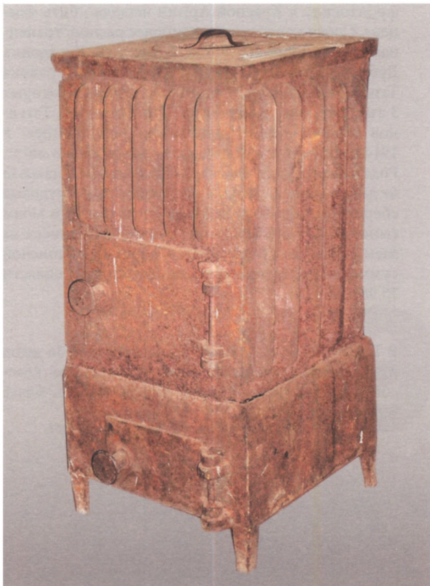
Такие разборные чугунные печи для блиндажей выпускали Майковский и Пожвинский металлургические заводы
