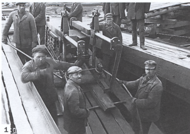
1. На пермской судовой верфи такелажная бригада спускает паровую машину в корпус парохода. 1936 г.
