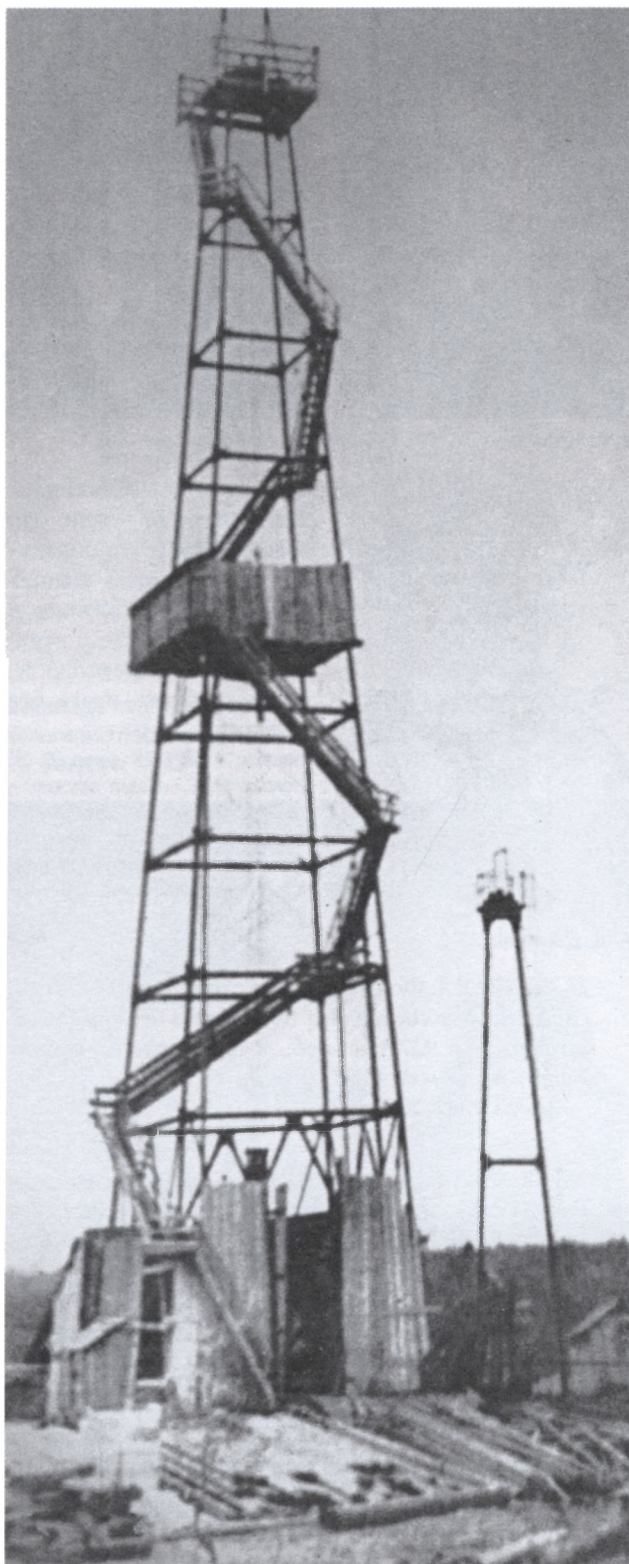
Буровая установка для турбинного бурения кустовых скважин. Краснокамск
