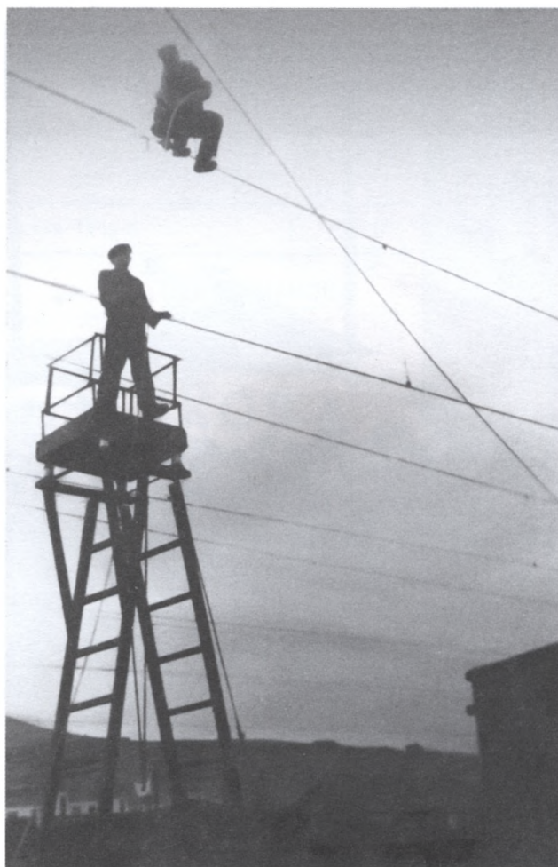
Монтаж проводов на линии Пермь II – Чусовская
