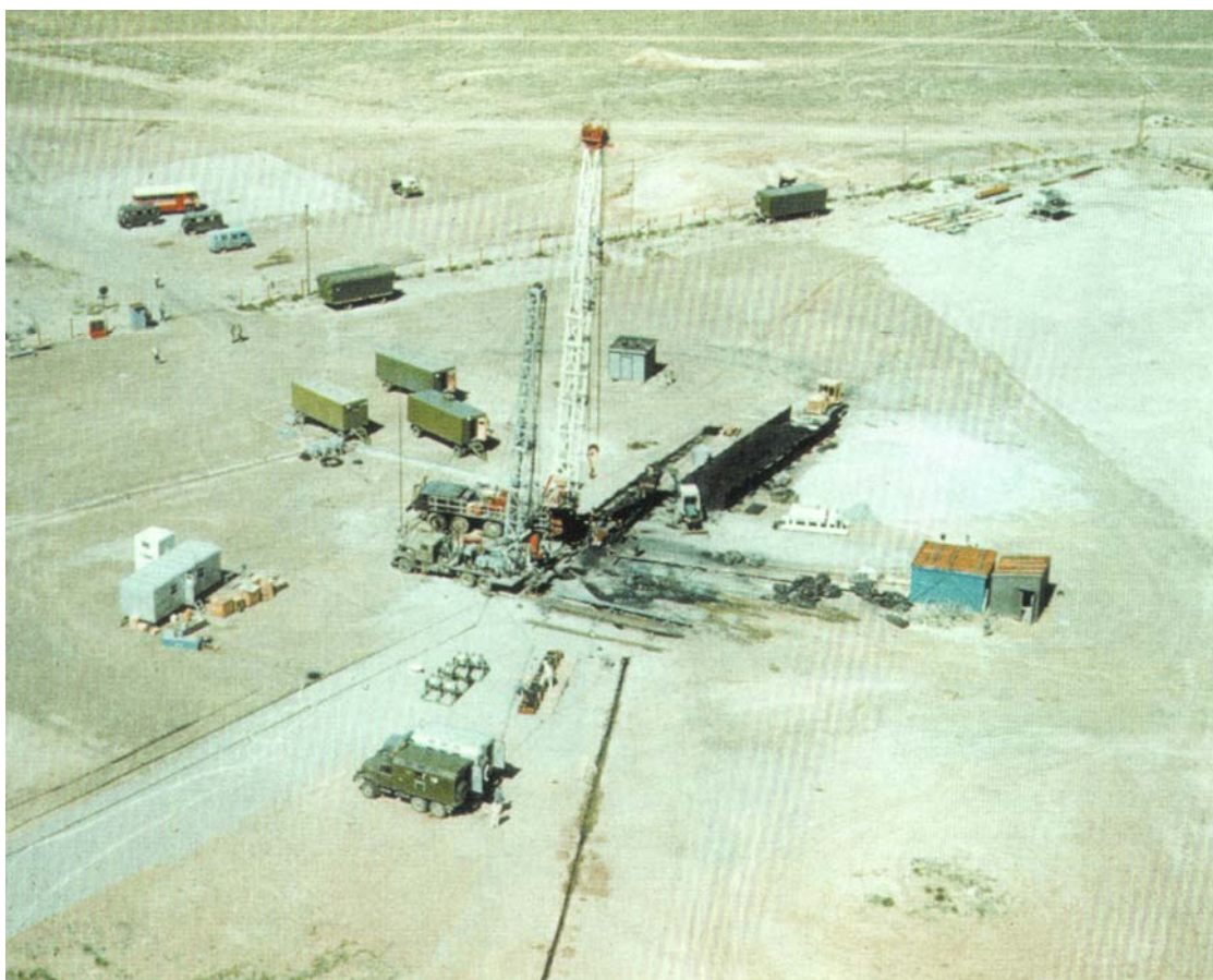
Подготовка совместного советско-американского эксперимента по контролю за ядерными испытаниями. Семипалатинский испытательный полигон. Ядерный заряд установлен в скважине.
