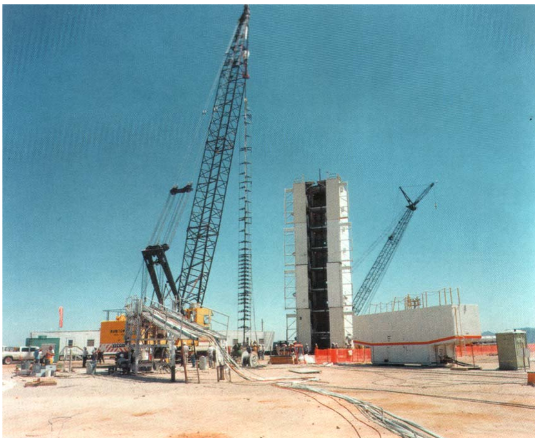
Подготовка совместного советско-американского эксперимента по контролю за ядерными испытаниями. Невадский испытательный полигон. Подготовка к спуску колонны в скважину.
