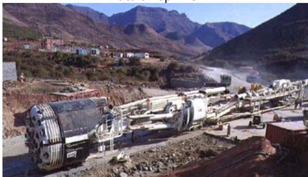
Бурильная машина для изготовления туннелей
